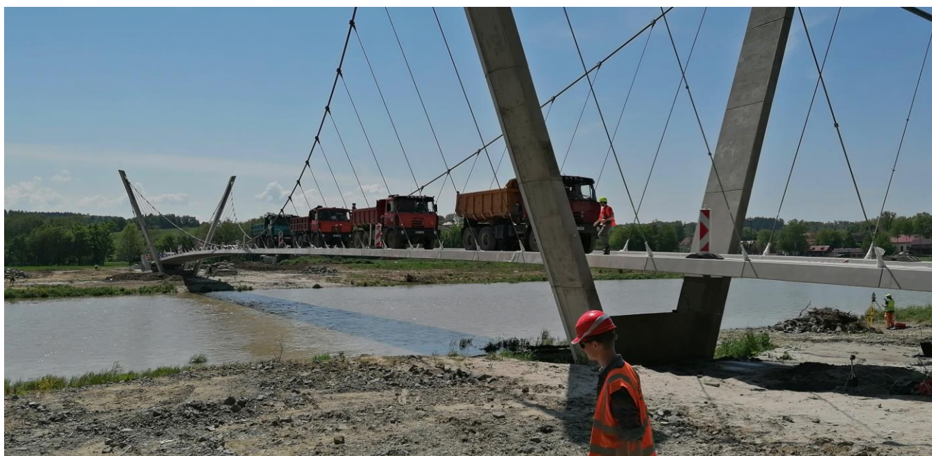
Zátěžová zkouška lávky přes řeku Bečvu nedaleko Hranic na Moravě, na jehož stavbě / tlumení kmitání (laděné hmotnostní tlumiče kmitů – TMD, pohlcovače kmitů) se podílí KGF hydraulika.
