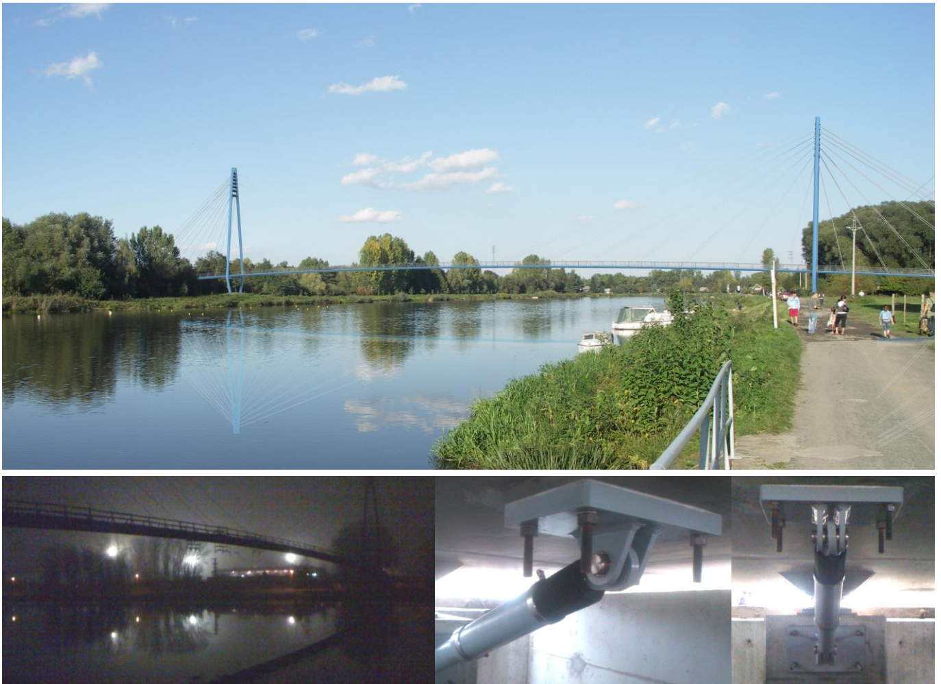
Viskózní tlumiče kmitů na cyklistické lávce přes Labe v Čelákovcích
