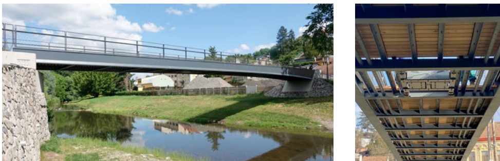
Obr. 4 Lávka pro pěší v přes řeku Svitavu v Bílovicích nad Svitavou
