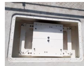
Obr. 6 Uložení tlumiče v komoře
