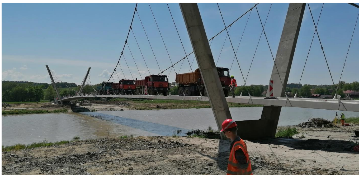
Zátěžová zkouška lávky přes řeku Bečvu nedaleko Hranic na Moravě, na jehož tlumení kmitání (laděné hmotnostní tlumiče kmitů – TMD, pohlcovače kmitů) se podílí KGF hydraulika.
