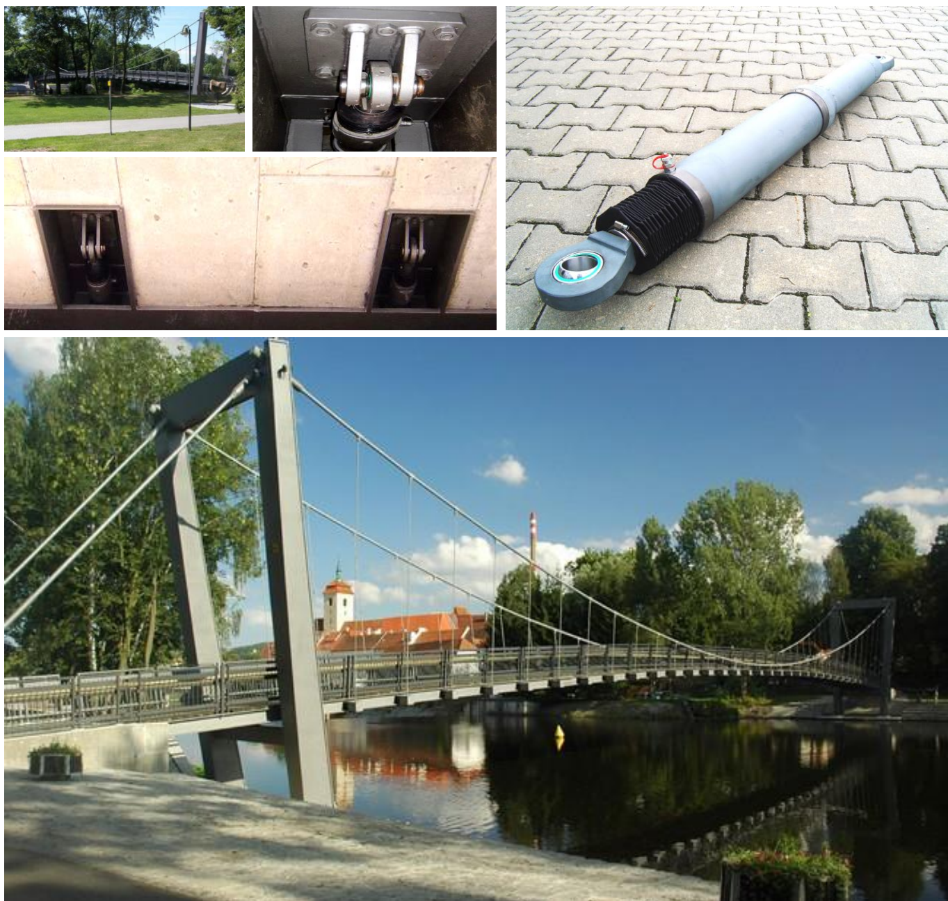
Hydraulický tlumič kmitů na lávce ke Strakonickému hradu
