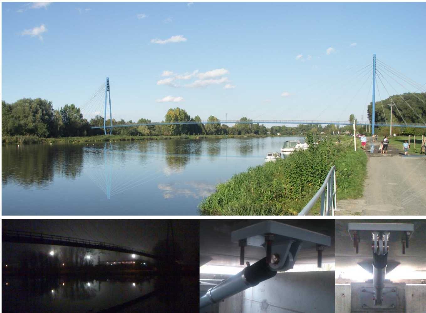
Hydraulický tlumič kmitů na cyklistické lávce přes Labe v Čelákovících
